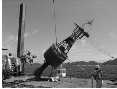
灯浮標の設置
