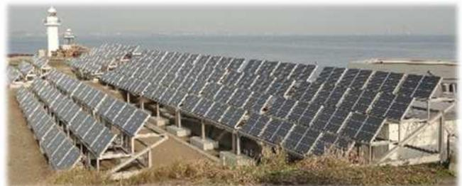
〔写真：灯台用として日本最大の5万Wの発電量を誇る第二海堡灯台（千葉県）〕
