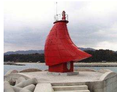
淡輪港西防波堤灯台（大阪府泉南郡岬町）本港で開催された国体ヨットレースに因んだデザインです。
