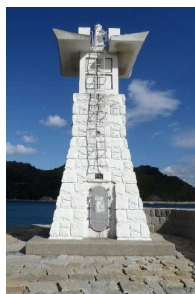
みたらいこうぼうはいてい 御手洗港防波堤灯台（広島県御手洗港） 港周辺に現存する江戸時代の建物群に溶け込むデザインとなっている
