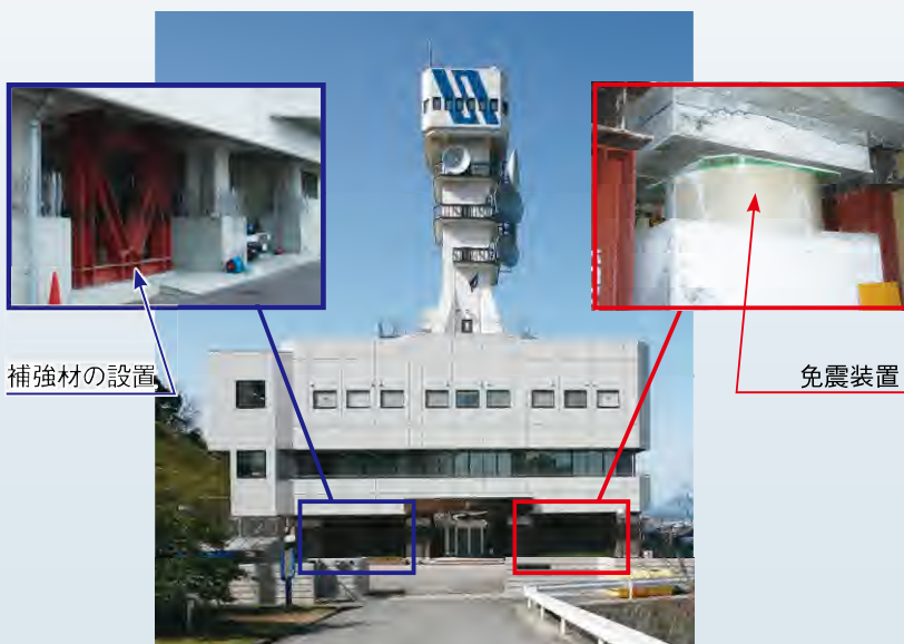
海上交通センターの耐震補強
