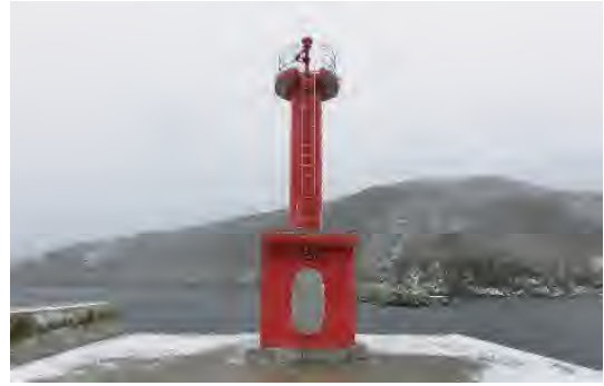
綾里港東防波堤灯台（岩手県大船渡市）
