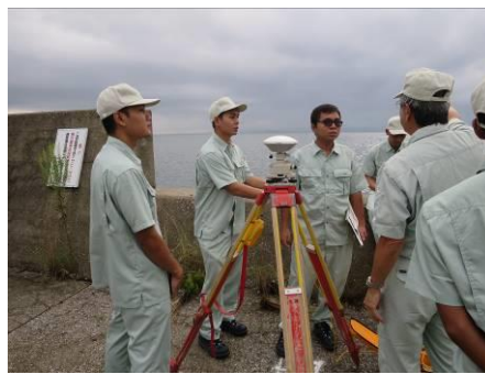
陸上での測量作業の様子(GNSS 測量)
