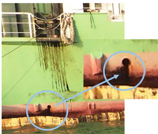
給油作業時のバルブ開閉不確認により、甲板上に漏れ出た油がスカッパー（排水孔）に流れ込み、海面近くの排水口から海上に排出（黒色が油）
