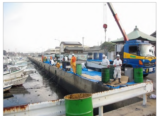
対岸の漁港内での油防除作業
