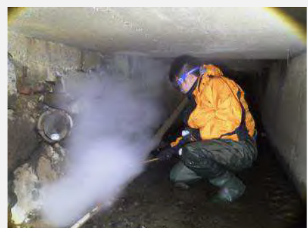
捜査員が排水口からの採水を行う様子
