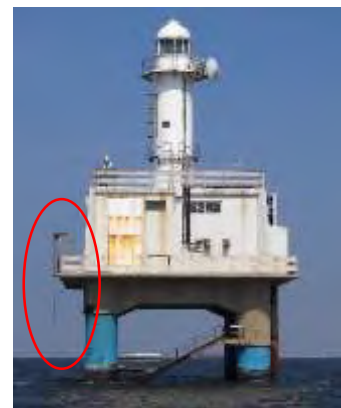
千葉灯標に設置されている モニタリングポスト (図中赤線内)
