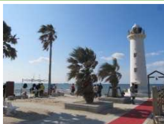
公園・遊歩道整備(野間埼灯台)
