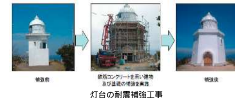
灯台の耐震補強工事
