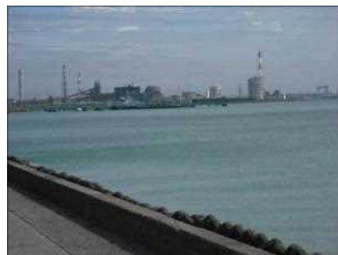
写真：千葉港（平成23年8月30日）
