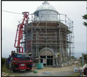
▲鉄筋コンクリートを用い建物及び基礎の補強を実施
