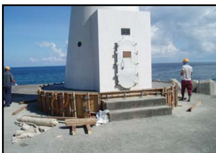
▲波浪にさらされる基礎部分を補強
