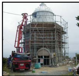
▲鉄筋コンクリートを用い建物及び基礎の補強を実施
