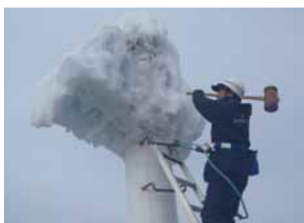
雪の多い地域だけに冬場は灯台が氷で覆われることも。氷の除去作業も大変だが、灯台の痛みも進むため、より頻繁なメンテナンスが必要となる。
