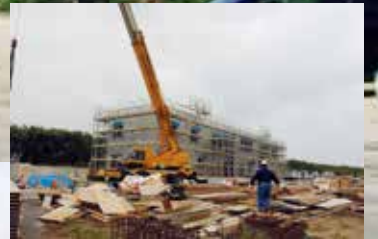
巡視船基地となる伊良部島・長山港には現在、船艇用品庫が建設中だ。
