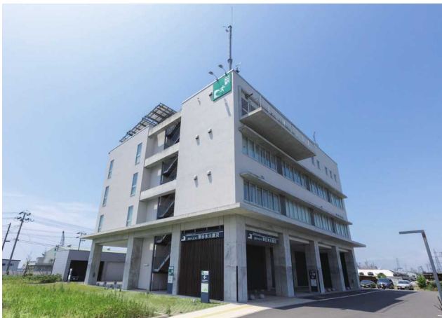
防災機能を強化し新築された石巻海上保安署
