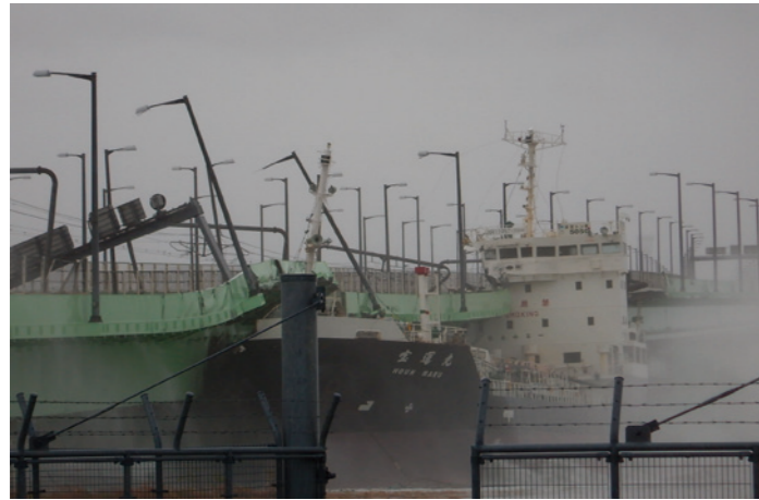
関西国際空港連絡橋にタンカーが衝突した状況
